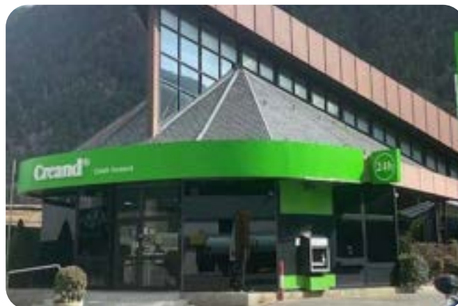
Plaques fotovoltaïques a l'oficina de Santa Coloma.
