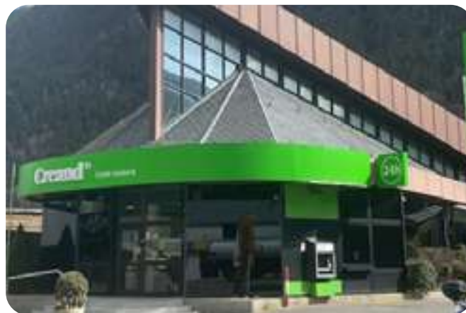
Plaques fotovoltaïques a l'oficina de Santa Coloma.
